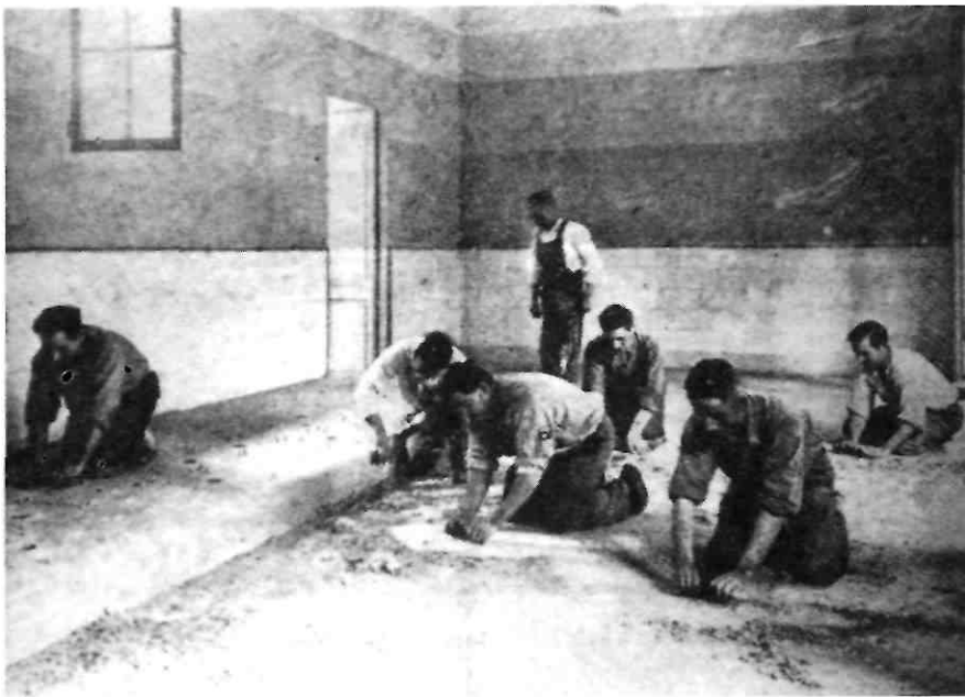
Obrers de l'Agrupació Col·lectiva de la Construcció de Barcelona construint un paviment atèrmic.
