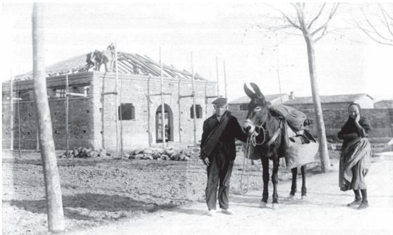
Parella d'avis amb una burra vigatana guarnida amb albarda i alforges, en el seu pas prop de l'Esperança en construcció, tornant cap a casa carregats de productes del mercat de Vic. (ACOS) Autor: Robert.
