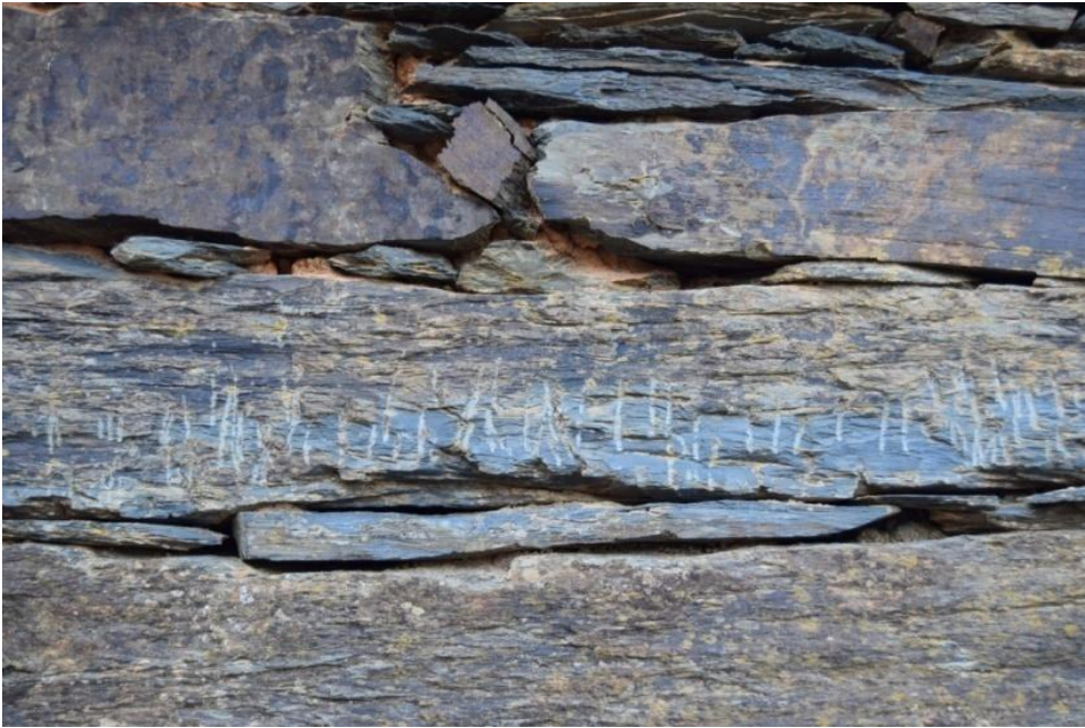
Material pizarroso empleado en la construcción de una vivienda tradicional (Fradellos).
